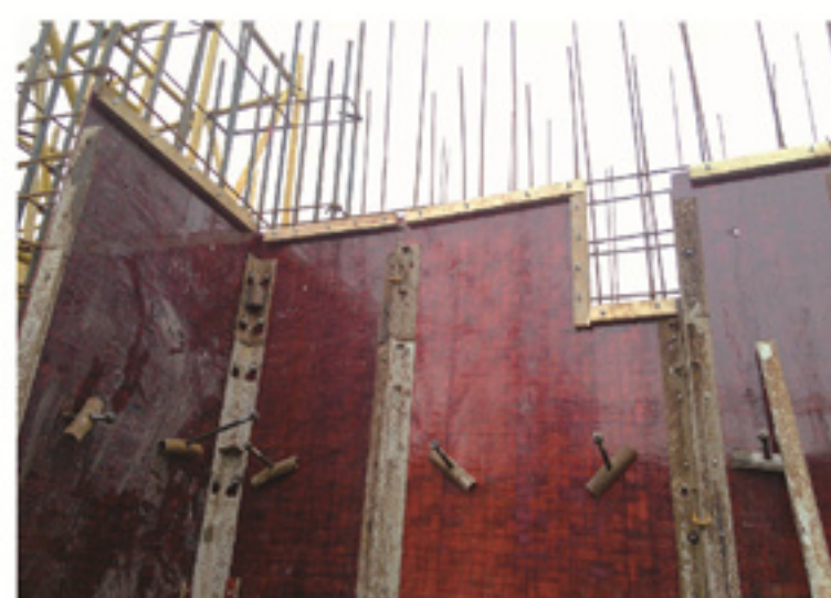
附图：钢框竹胶模墙板
